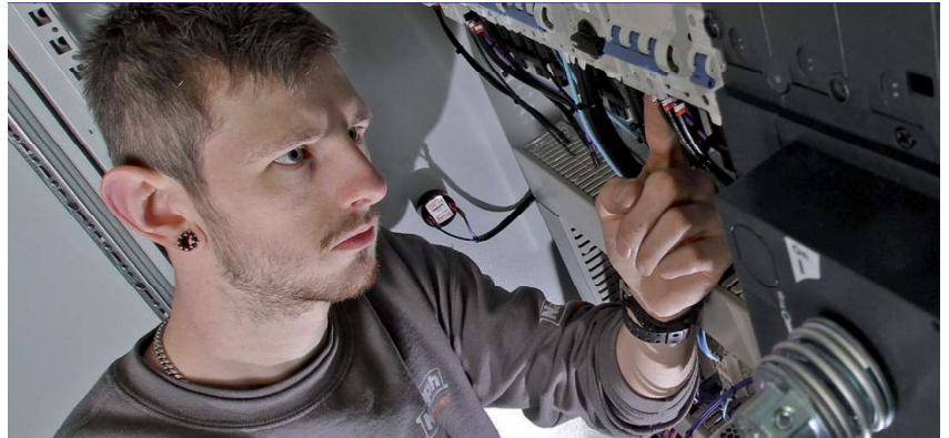
Wartungs- und Pflegearbeiten, Service- und Reparaturarbeiten
