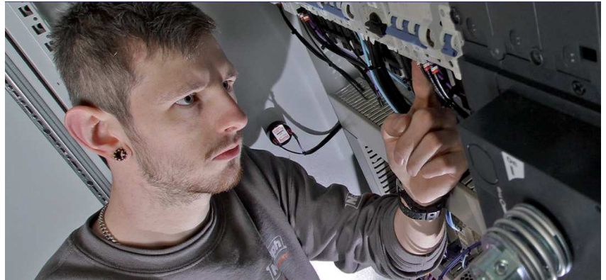
Wartungs- und Pflegearbeiten, Service- und Reparaturarbeiten
